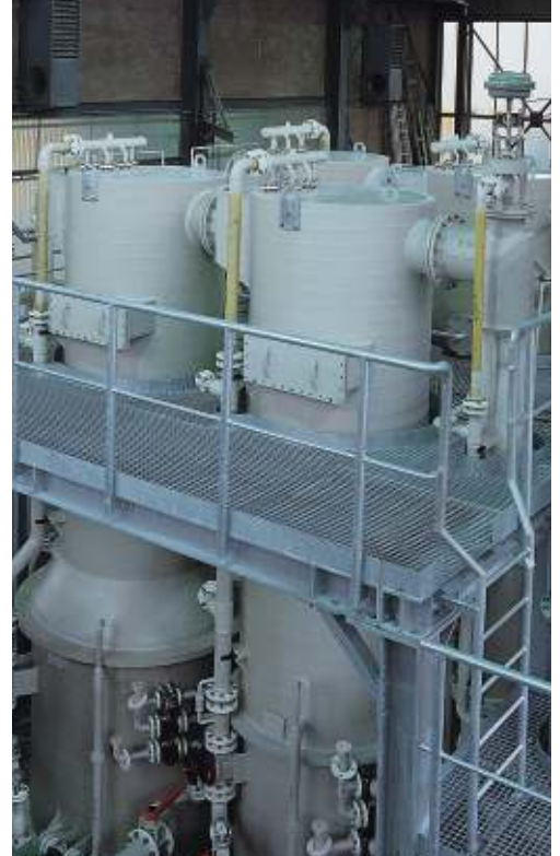
Lavador tipo jet modelo II para gases de escape alcalinos y ácidos
